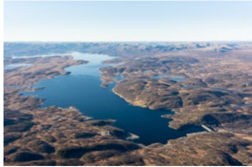
Møsvatn – hovedvannkilden for kraftverkene i verdensarvområdet. Dammen til høyre.
