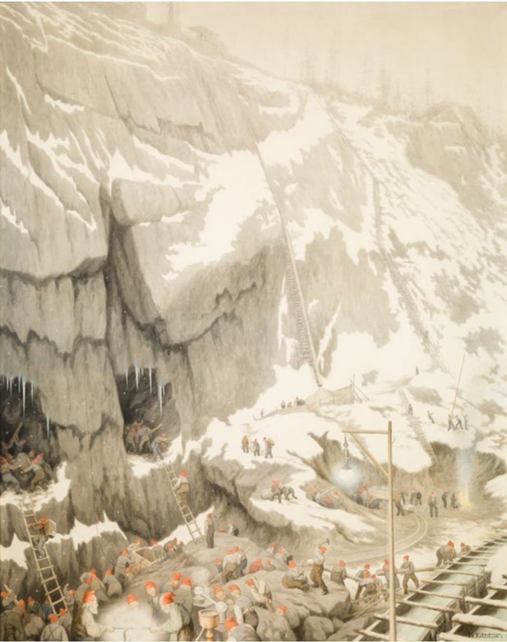
«Grunnarbeide» Her ser vi at det er blitt et yrende liv i fjellet. Det er nissene som temmer naturen med sine byggearbeider. De graver og minerer, leder vannet i renner. Vi ser også at de holder på med en elektrisk flamme og steller med kjemiske apparater. Disse elementene var det Sam Eyde som ville ha med i bildet. Fordi disse virksomhetene har vært like betydningsfulle som byggearbeidene, mente han.
