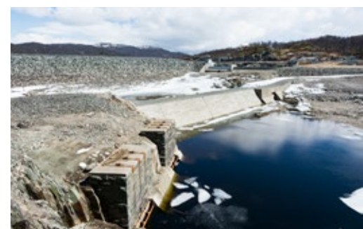
Møsvassdammen kan være utgangspunkt når tema er arealbruk, ressursbruk og miljø. Foto: NIA
