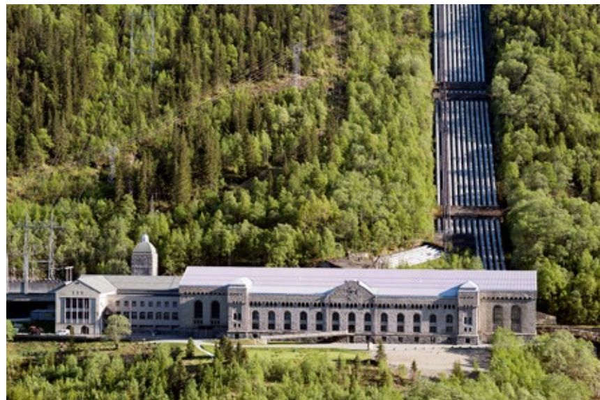
Vemork kraftstasjon var i sin tid verdens største kraftverk. Foto: Per Berntsen
