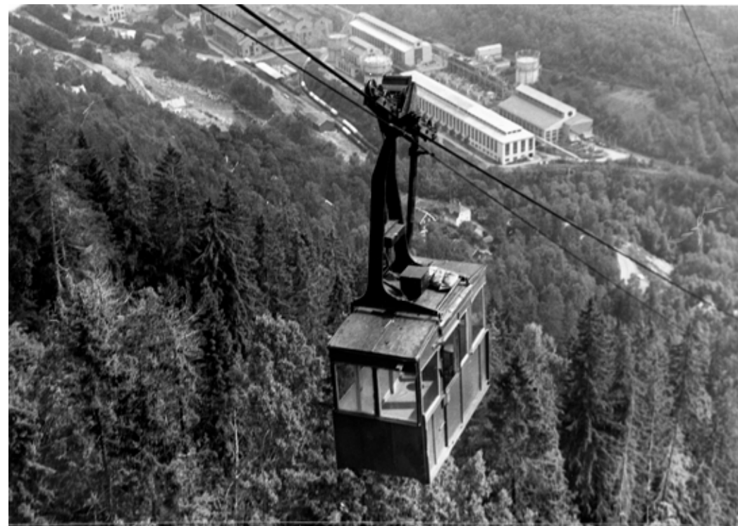
Krossobanen ble bygd i 1927 av det tyske firmaet Adolf Bleichert AG, som også var arkitekt. Den var Nord-Europas første svevebane for personbefordring, med åpning i januar 1928. Krossobanen er en kabelbane og der øverste stasjon på Gvapseborg ligger på 890 moh. Norsk Hydro sto for drifta fram til oktober 1987, da Tinn kommune overtok. Den røde og den blå gondolen er kalt Tyttbæret og Blåbæret. Foto: NIA
