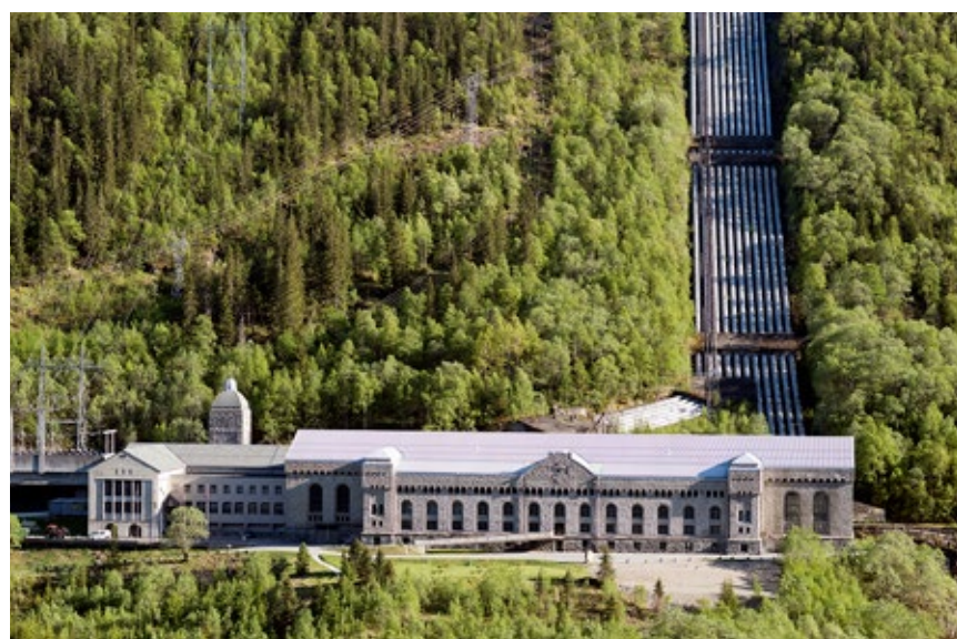
Vemork kraftstasjon var i si tid det største kraftverket i verda.
