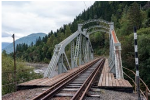
Storemo bru på Tinnosbanen. I alt har strekninga 14 bruer og fem tunnelar. Foto: Per Berntsen
